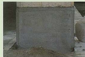
断面修復材の施工
