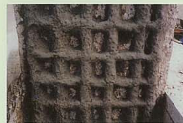
防錆材 (RJ1、RJ2) の施工
