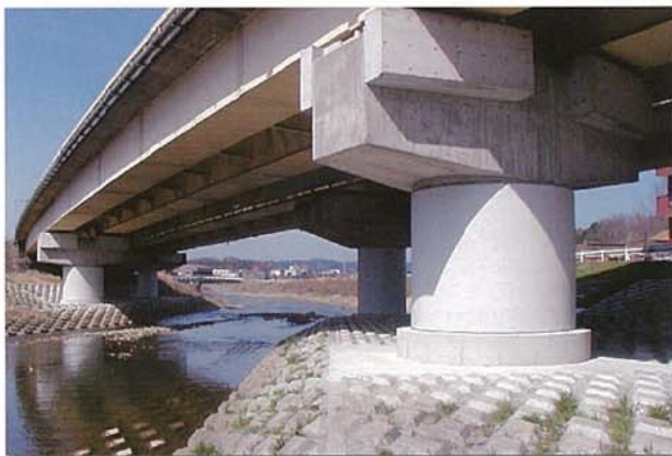
【鋼板巻立ての防錆塗装】
