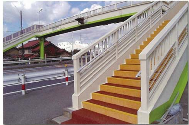
【鋼製歩道橋の滞水部の防錆(ゴム弾性舗装済)】
