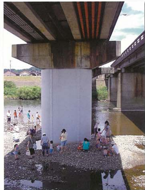
【鋼板巻立ての防錆塗装】
