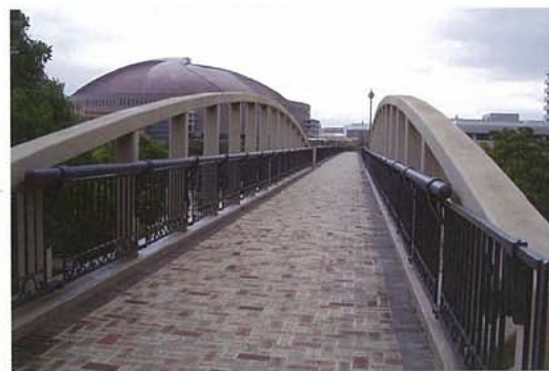
2010年 現在 トップ塗料の退色はありますが、発錆は全くありません。
