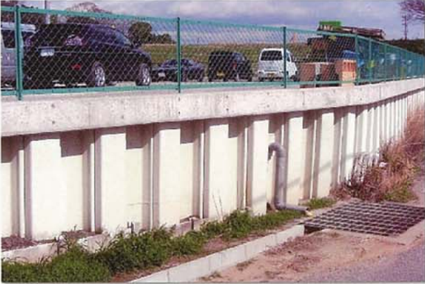
【鋼矢板の防錆】
