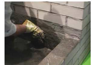
KD2 で仮止水
