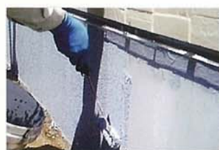
ローラー引き作業
