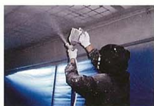
吹き付け作業
