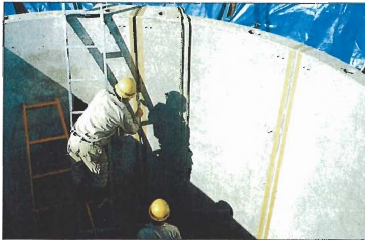
プライマー塗布 (アルプロンW-305を刷毛塗り)
