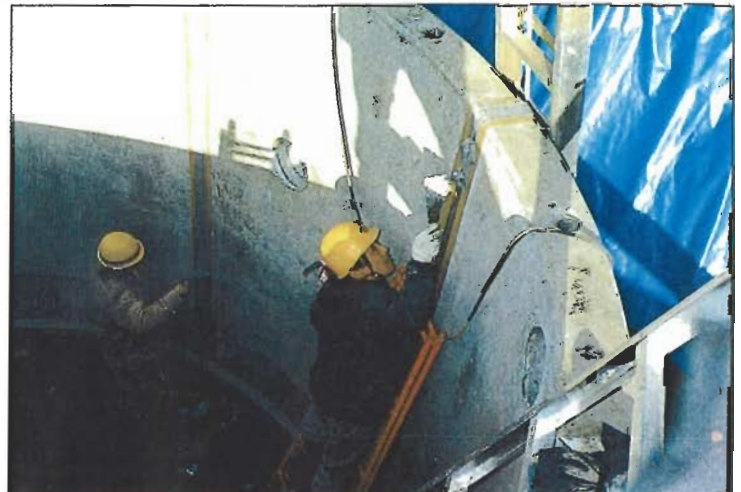
コーキング作業 (アルプロンSをヘラにて充填中)
