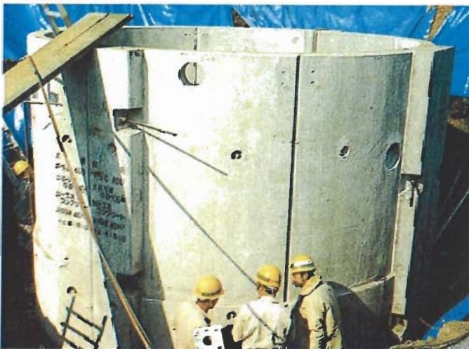
東京都新宿区戸山公園防火水槽目地コーキング
