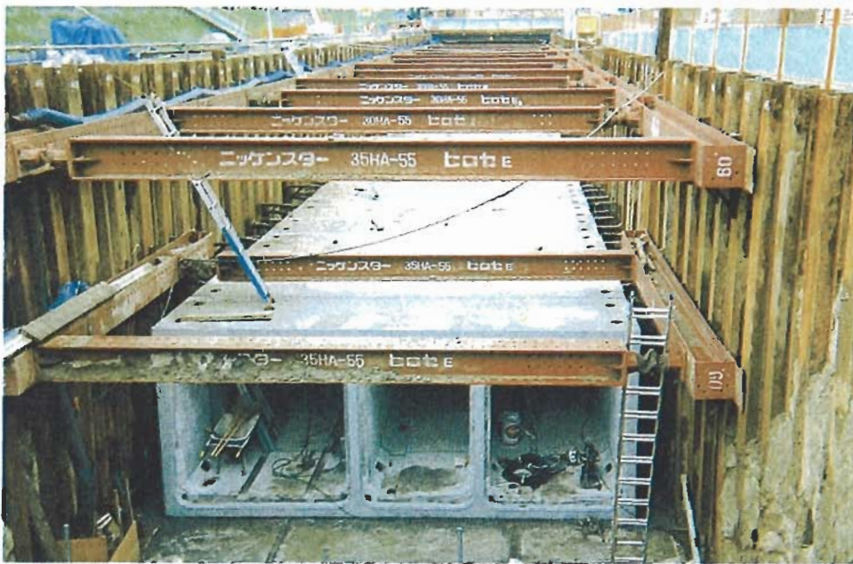
建設省広島国道工事事務所共同溝ガス室目地コーキング
