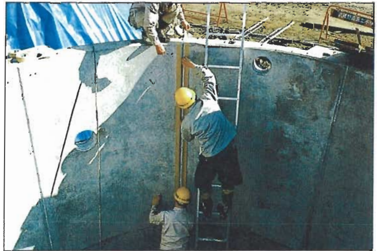
養生 (養生テープ貼り付け)
