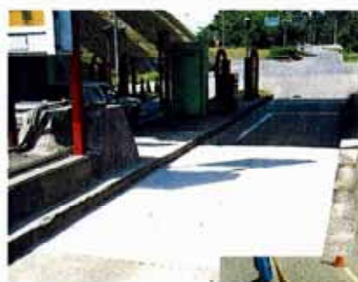
料金所ブース補修
