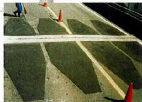
伸縮装置部 段差修正
