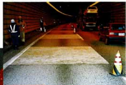
舗装版段差修正
