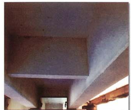
【主桁・床版の補強】
