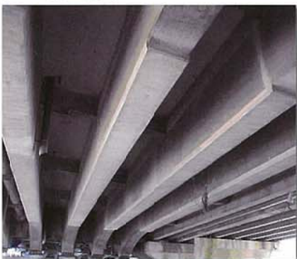
【RC主桁の補強】
