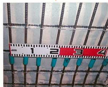
補強鉄筋取付工
