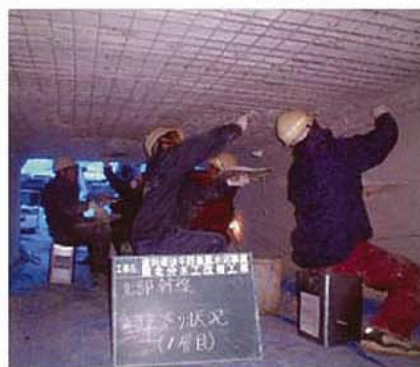
【ボックスカルバートの頂版補強】
