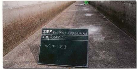
超高圧水ケレン
