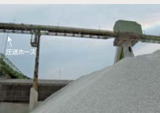
▲地上 30m 地点での作業
