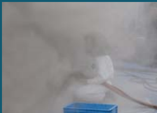
従来工法での吹付け
