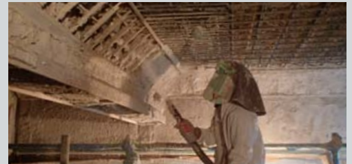
下水処理施設吹付け状況
