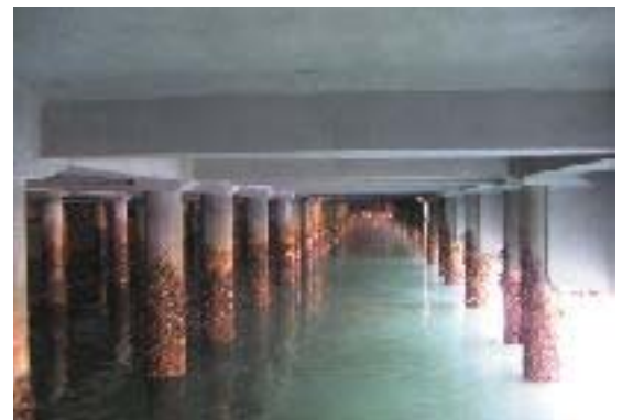
リフレベースW塗布状況 (リシンガン吹付け施工)
