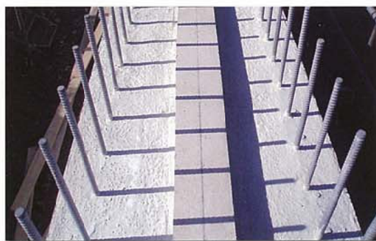
【打継ぎ部の施工完了後】
