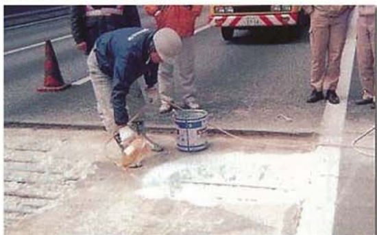
【ポットホールの補修事例】
